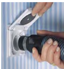
ein Loch in der Wand
